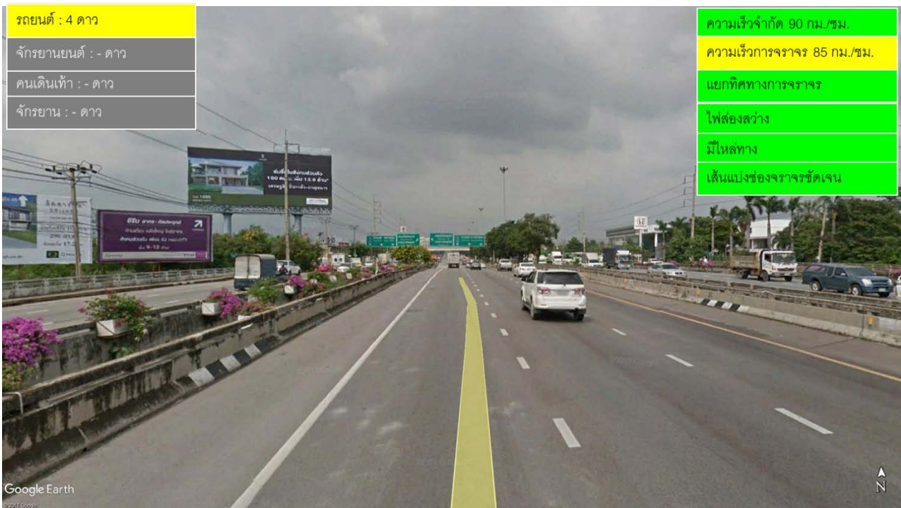
รูปที่ 12 ทางหลวงหมายเลข 9 ตอนที่ 102
