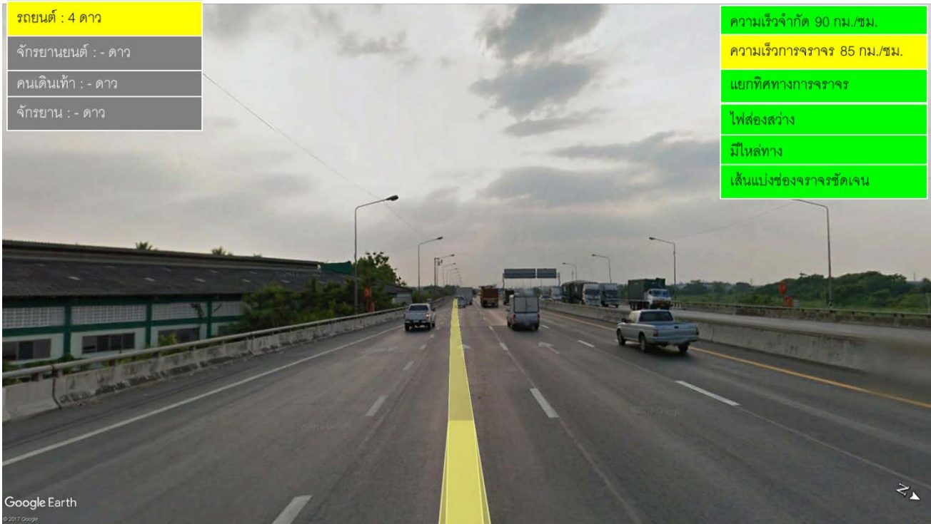
รูปที่ 11 ทางหลวงหมายเลข 9 ตอนที่ 101
