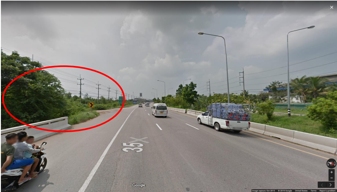
รูปที่ 23 ตัวอย่างสภาพสายทางที่มีสิ่งกีดขวางที่บดบังวิสัยทัศน์
